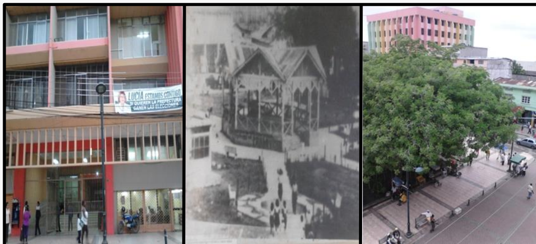
Ilustración 20. Izquierda, alcaldía de Esmeraldas, centro, antiguo kiosco parque central, derecha, parque central 20 de marzo con vista parcial al fondo, del edificio del gobierno provincial de Esmeraldas
