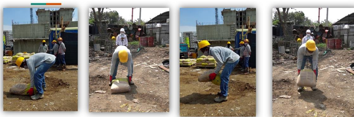
Figura 5. Etapas del levantamiento y segmentos articulares evaluados en cada trabajador.
