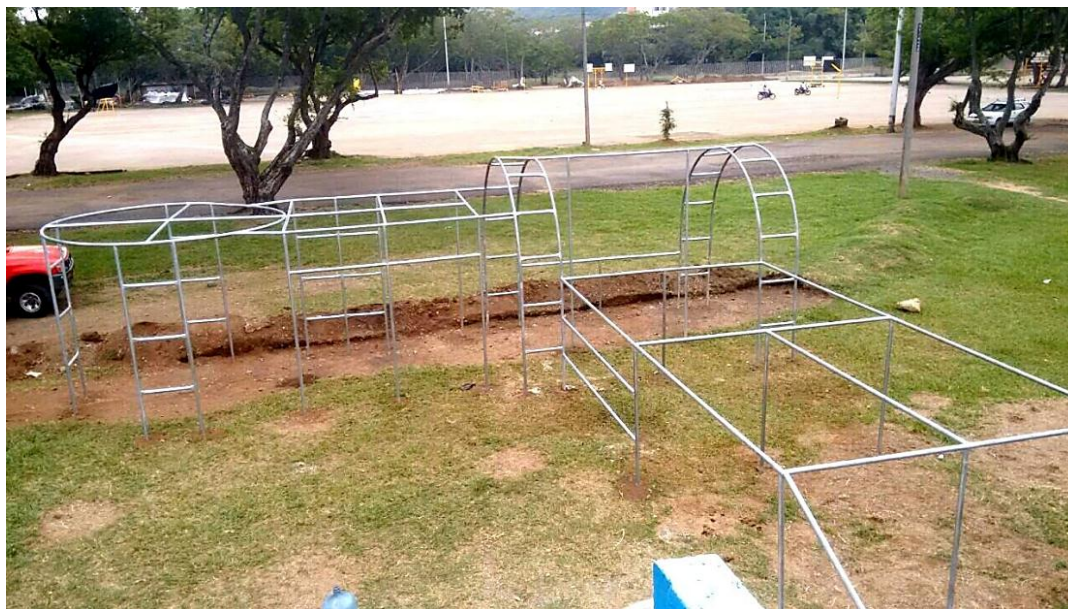
Foto 8: Estructura de Tubos Muro Parkour_ Fuente Grupo Facebook Sifakas
