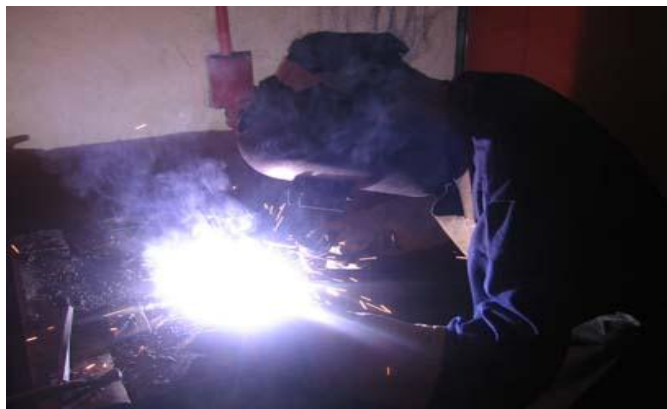
Ilustración 23 Proceso de soldadura
