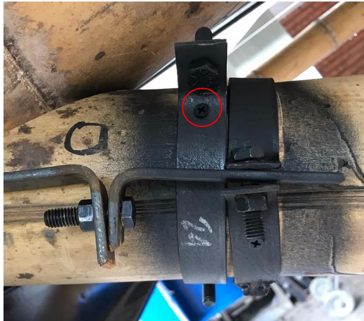
Figura 4-10 Detalle abrazadera fijada con tornillo autoperforante. Circulo rojo. (Valencia Hernández, 2018)
