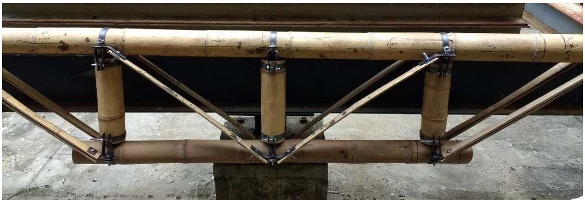
Figura 3-12 Primer prototipo de cercha construida.
