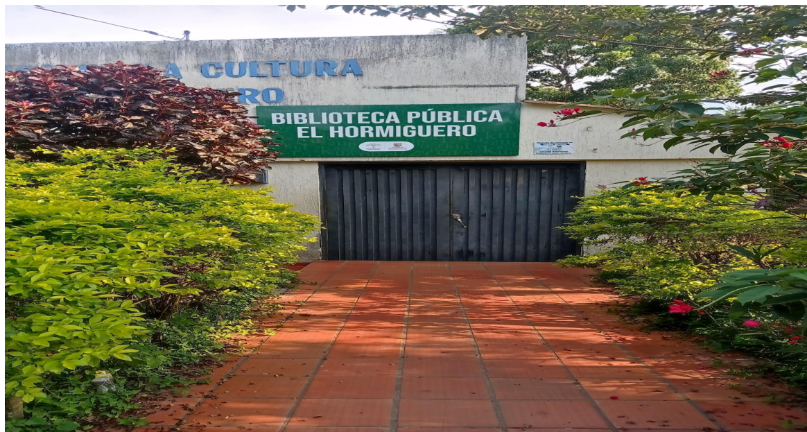
Fotografía 7. Biblioteca pública de El Hormiguero
