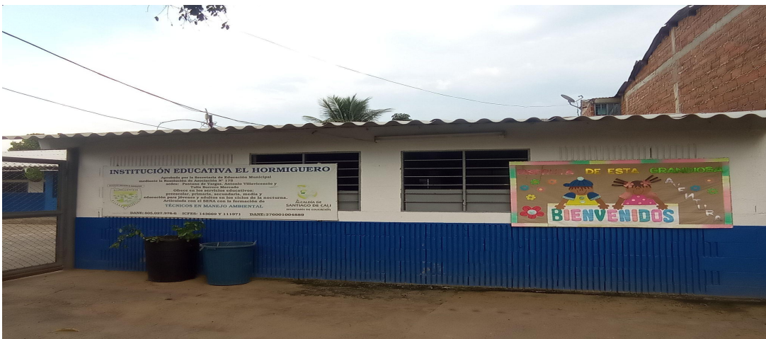
Fotografía 4. I.E. El Hormiguero sede Antonio Villavicencio.
