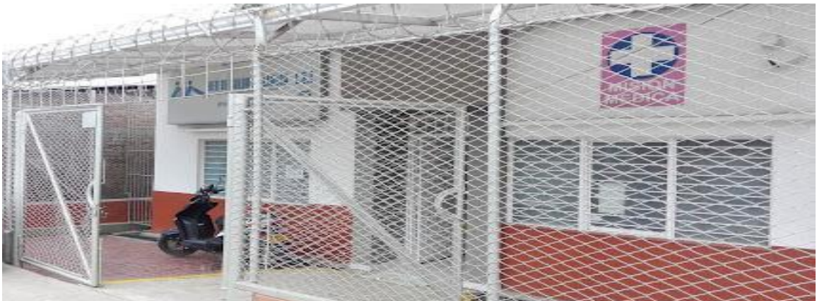
Fotografía 6. Puesto de salud de El Hormiguero
