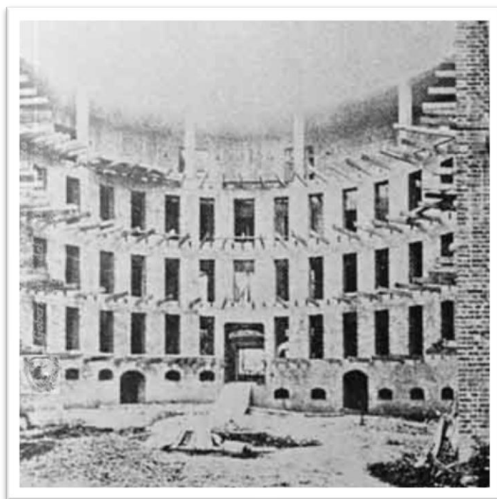
Figura 11. Construcción del Teatro Municipal, Cali 1924.
