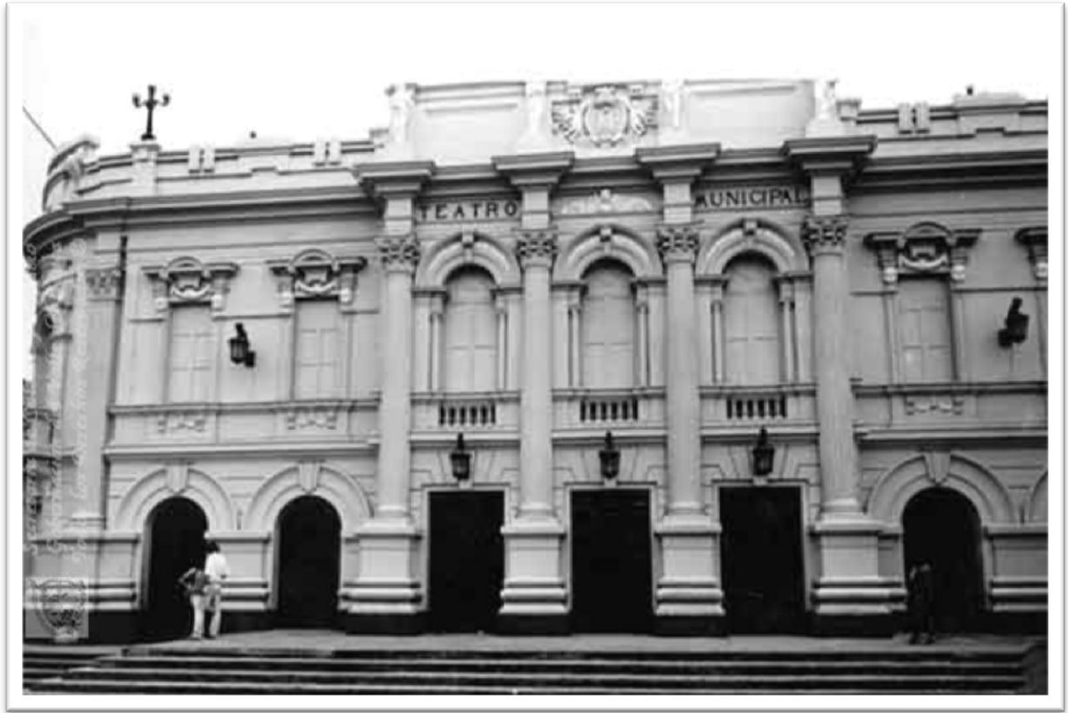
Figura 12. Fachada norte del Teatro Municipal de Cali.
