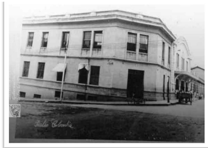
Figura 14. Fachada lateral del Teatro Colombia desde donde se aprecia también la entrada.
