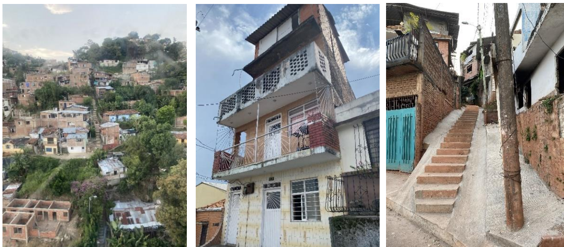
Figura 3. A la izquierda: Vista de la topografía de Siloé desde el MIO Cable. Centro: Autogestión de vivienda por etapas. Derecha: Pasaje de gradas para el acceso en la ladera. Fuente: Propia.
