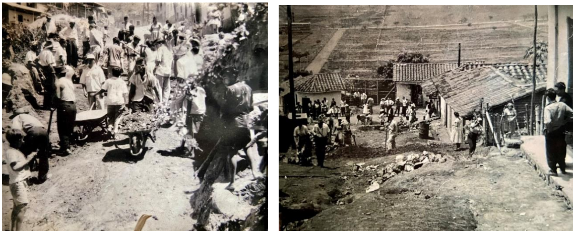
Figura 29. Trabajos en comunidad en Siloé. Fuente: archivo histórico Museo Popular de Siloé.
