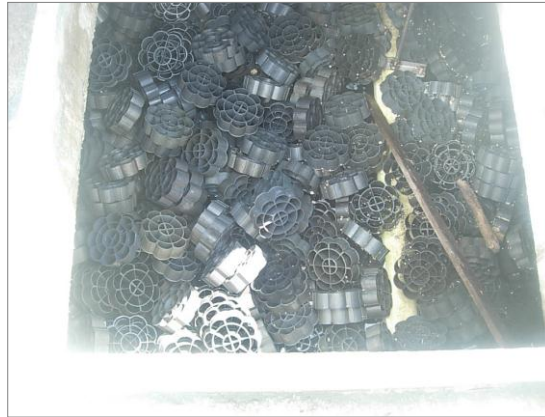
Foto 4. Rosetas plásticas de filtro anaerobio
