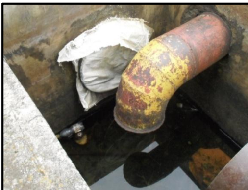
Imagen 51. Interior del tanque
