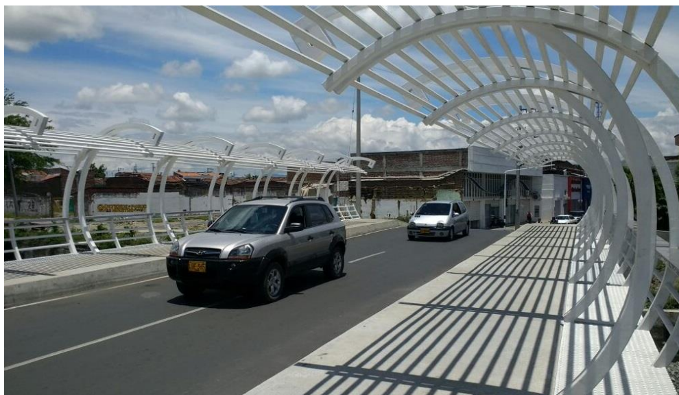
Ilustración 4. Puente en Tuluá ubicado en la calle 28 entre Cra. 28 y Cra. 30
