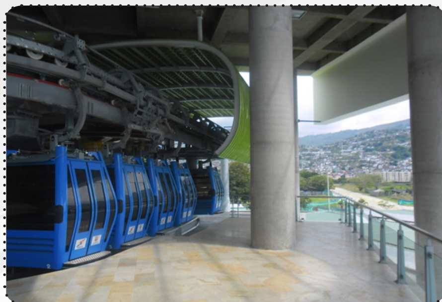
Imagen 7, M.I.O Cable, EL PUEBLO, (n.d), Recuperado de http://elpueblo.com.co/los-enredos-del-mio-cable/ .
