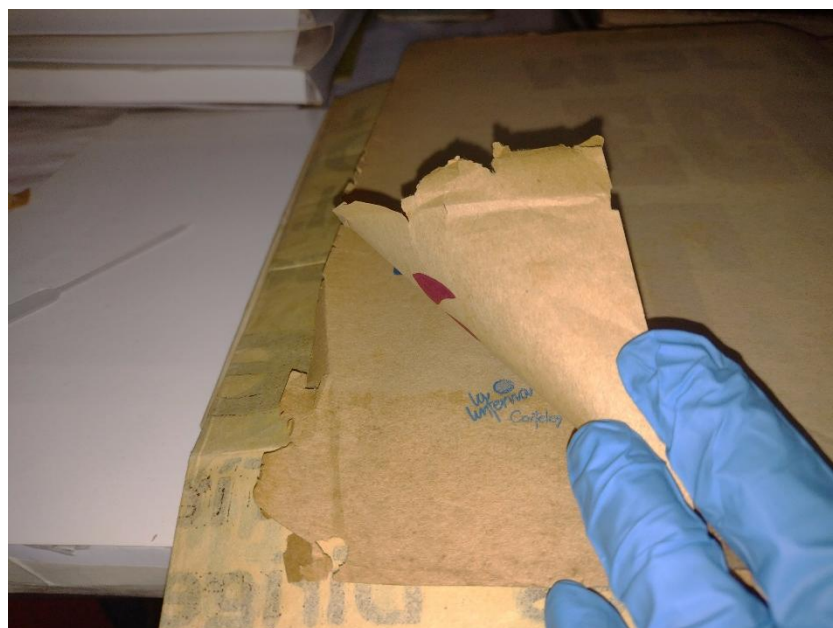
Figura 17. Deterioro en bordes de soporte de gran formato, Taller de títeres, Instituto Departamental de Bellas Artes, 2024, foto: Ángela Herrera.
