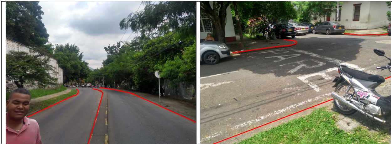
Ilustración 9. Ausencia de rampas de acceso para personas con movilidad reducida.
