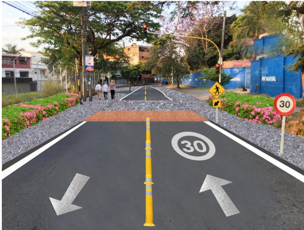
Ilustración 27. Mejora en la señalización horizontal y vertical en todos los tramos. En este caso se evidencia sobre el tramo 4b correspondiente a la Calle 4B.
