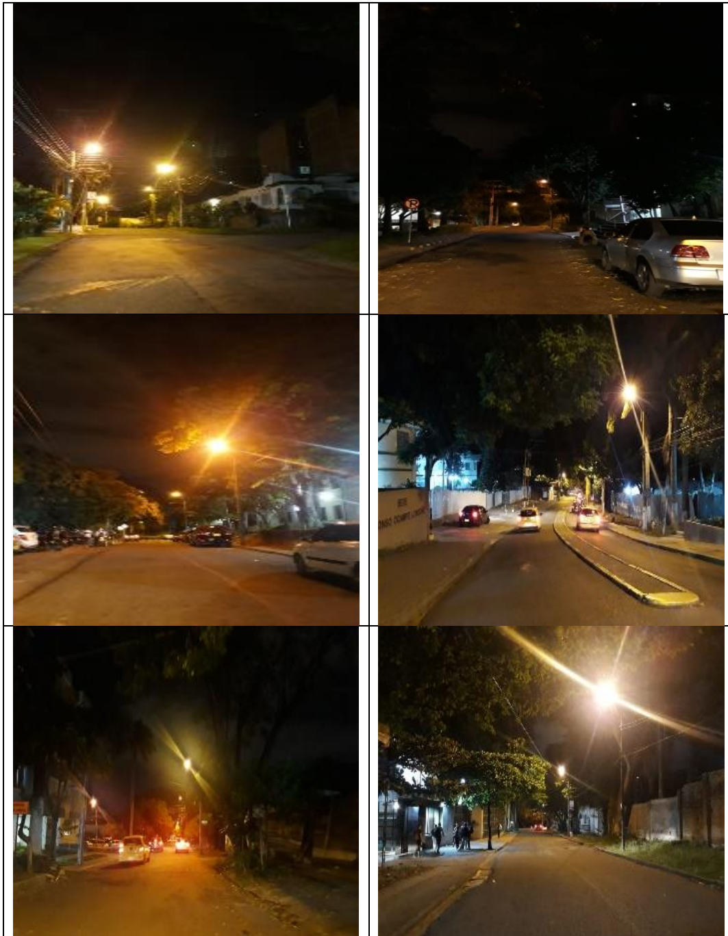
Ilustración 19. Estado de la iluminación.
