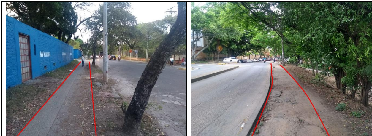
Ilustración 8. Inexistencia de superficies podotáctiles.
