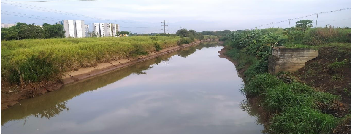
Figura 15. Vista del Canal Interceptor Sur, desde el barrio las Vegas de Comfandi comuna 17.
