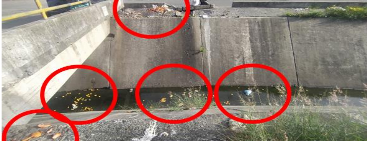
Figura 16. Canal secundario de agua pluvial desde el barrio Santa Elena.
