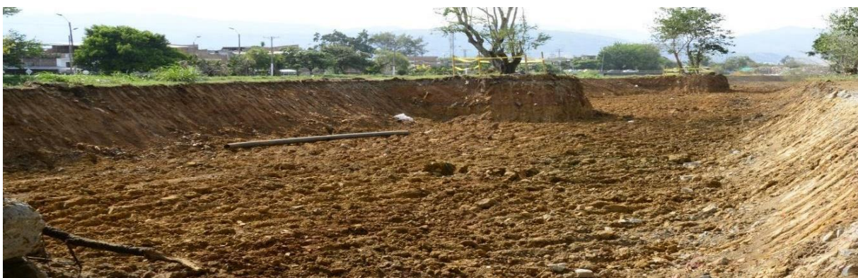
Figura 8. Reforzamiento y reconstrucción del jarillón a la altura del antiguo vertedero de Navarro.
