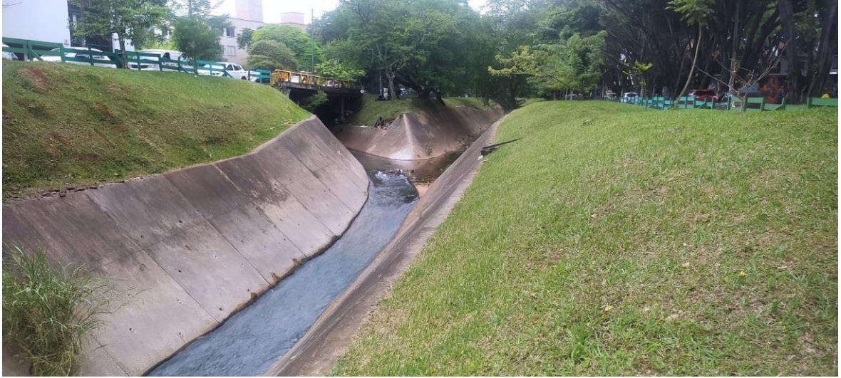
Figura 4. Toma fotográfica de la intersección entre la carrera 50 y calle 8F.
