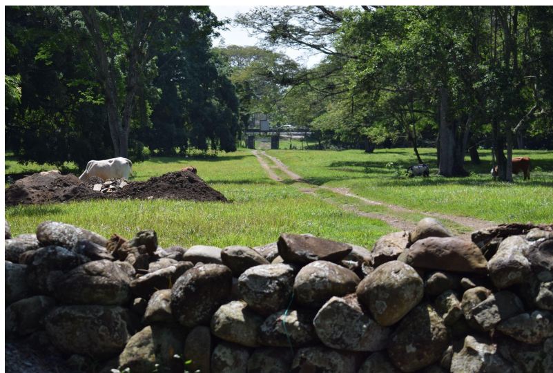
Figura 31. Muralla construida en la entrada de la hacienda
