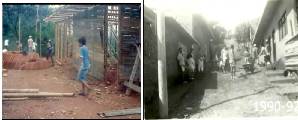
Imagen 43: Trabajos de autoconstrucción llevados a cabo por la comunidad: la escuelita Comunitaria las Colinas y pavimentación de calle 73 respectivamente - Fuente: Video “Conmemorativo CECUCOL” (2 de Diciembre de 2011) Centro Cultural Comunitario las Colinas, [Archivo de video] Recuperado de https://youtu.be/3AmIjo6vpTo
