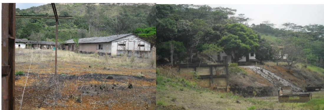
Imagen 30 y 31: Instalaciones abandonadas de la mina más conocida como Anchicayá - Fuente: Urrutia, Ibargûen Walter; Condiciones espaciales y socioculturales que permitieron la formación y consolidación del barrio Lourdes 1960-2000 Tesis pregrado. Mayo- 2017
