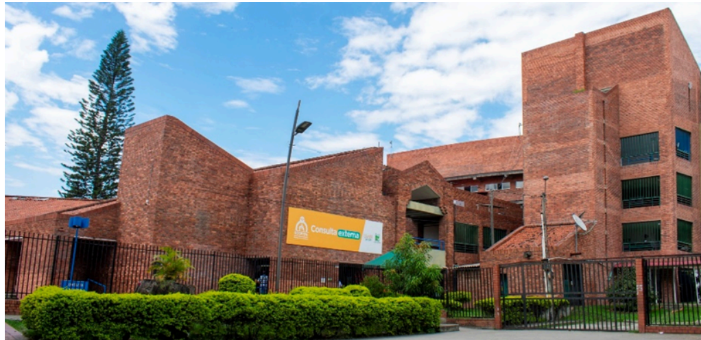
Imagen 8. Fachada Hospital Raúl Orejuela Bueno, Palmira, Valle del Cauca ( Maps, s.f.).
