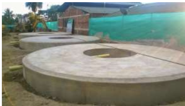
Fase de Cimentación de Construcción de Bodega y Oficinas Superagro, Guadalajara de Buga; 2014-2015.
