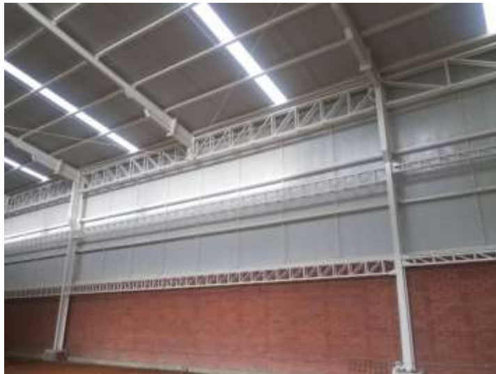
Finalización Fase de Montaje de Bodega y Oficinas Superagro, Guadalajara de Buga; 2014-2015.
