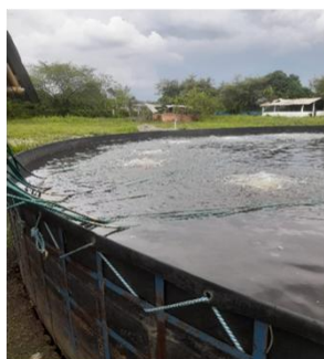
Tanque con geomembranas, mangueras y parrillas difusoras tipo trebol, en el fondo del tanque. Estas son las encargadas de generar el oxígeno que el cultivo de peces necesita
