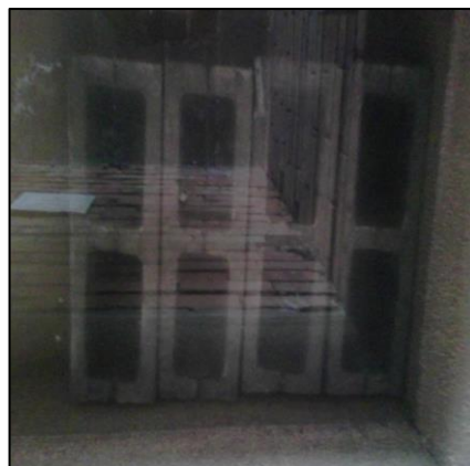
Figura 19. Bloques en proceso de curado
