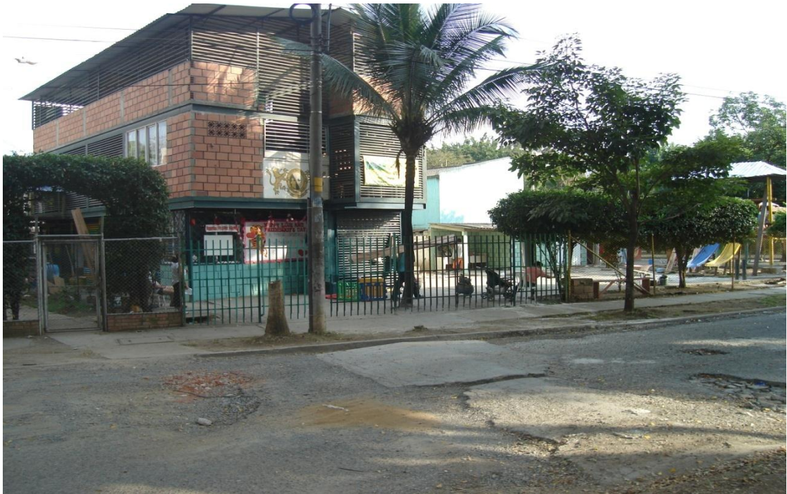
Imagen 4: Foto exterior de la Torre 1 Fuente: Archivo fotográfico de las autoras
