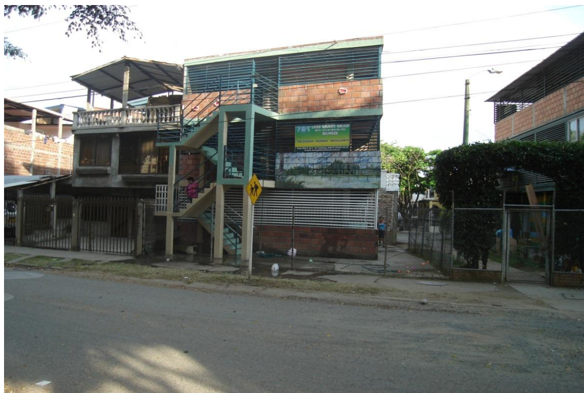
Imagen 6: Foto exterior de la Torre 2 Fuente: Archivo fotográfico de las autoras
