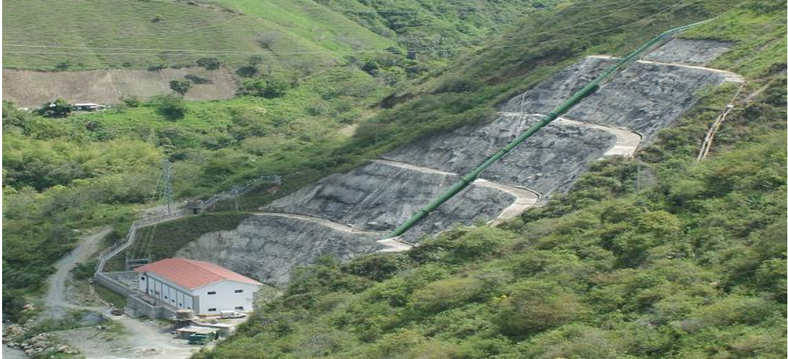
Foto 1. Panorámica Casa de Máquinas Central Hidroeléctrica Bajo Tuluá
