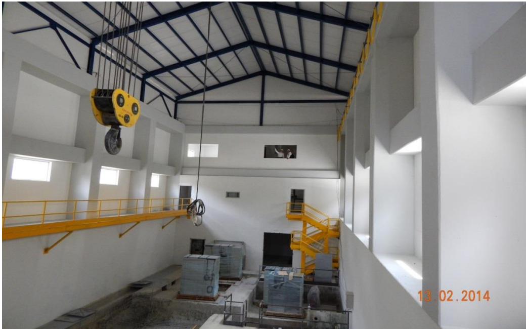
Foto 3. Casa de máquinas Proyecto Central Hidroeléctrica Bajo Tuluá
