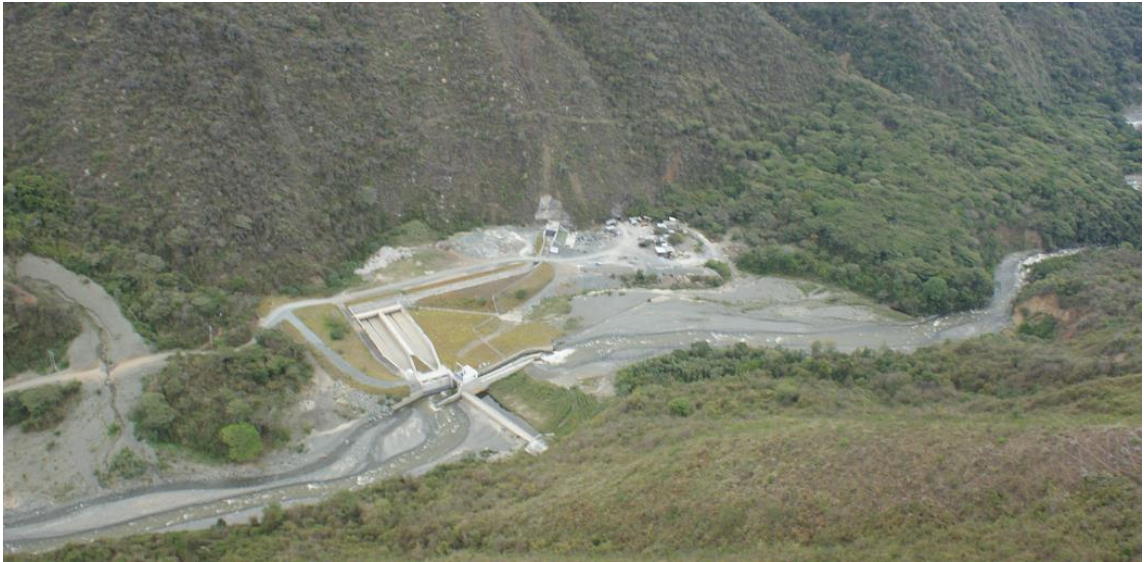
Foto 2. Foto panorámica de Captación Central Hidroeléctrica Bajo Tuluá
