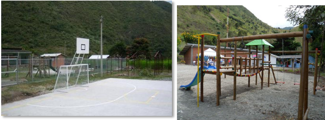
Foto 7. Reparaciones a infraestructura pública y mantenimiento a escuelas
