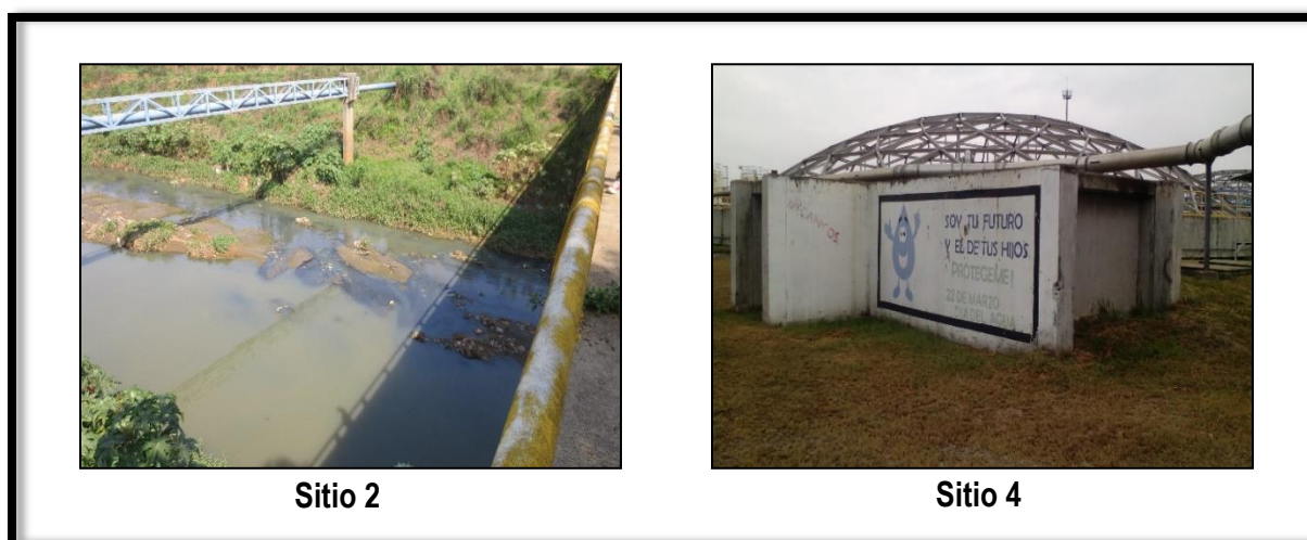
Figura 6. Efluentes municipales de la ciudad de Cali. A la izquierda Canal Sur y a la derecha descarga de la PTAR-C
