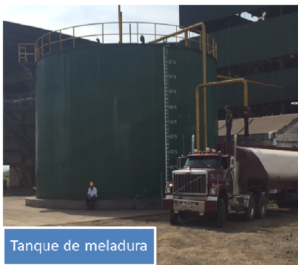
Figura 14: Fotos del tanque de meladura
