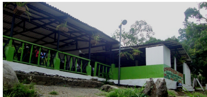
Imagen n° 6. Estadero “Piedra Grande”
