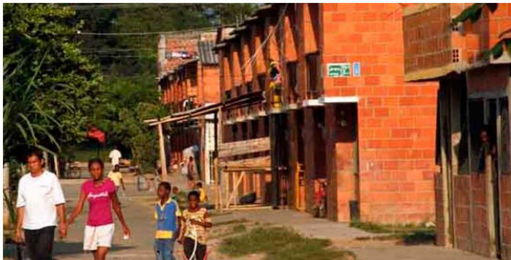
Figura 5. Infraestructura Barrio Llano Verde.
