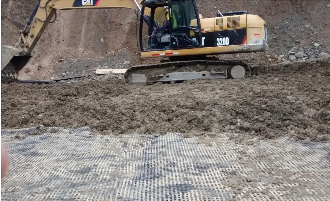
Figura 17. Colocación y regado del material de relleno con ayuda de retroexcavadora sobre geotextil Fordgrid UX 165, de acuerdo a metodología para la construcción del muro MSE con geosintéticos.
