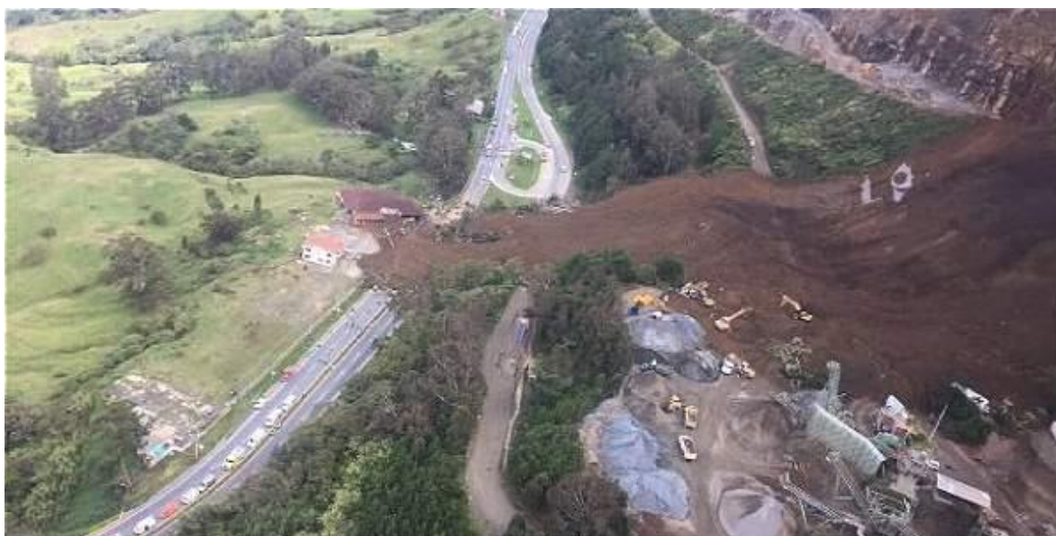
Figura 3. Derrumbe km 13 vía Medellín – Bogotá, cantera Las Nieves. (Fuente: El Tiempo)
