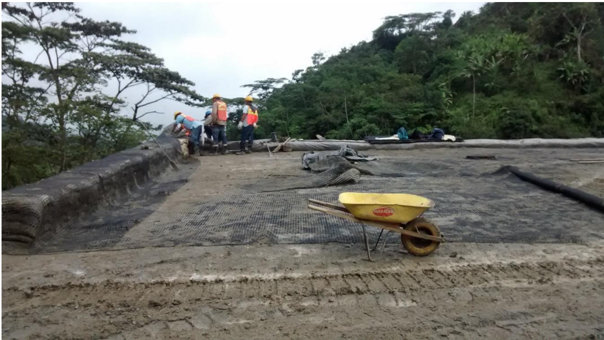
Figura 16. Formaleta de sacos envueltos del geotextil Fordgrid UX 165, de acuerdo al esquema general de armado del muro MSE con geosintéticos.
