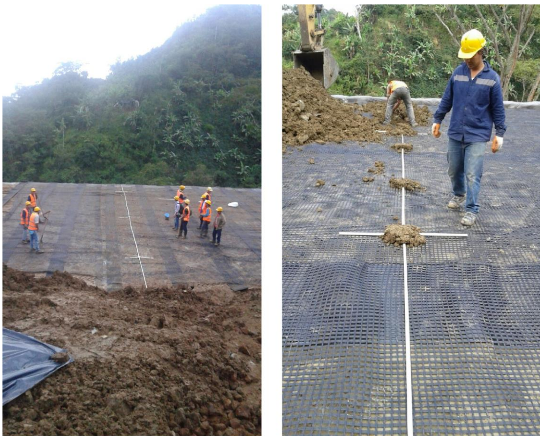
Figura 34. Colocación del instrumento para medir deformación.
