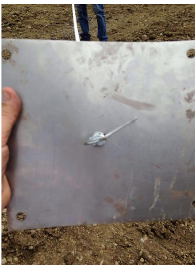
Figura 36. Placa rígida que fue anclada en la parte trasera del muro.
