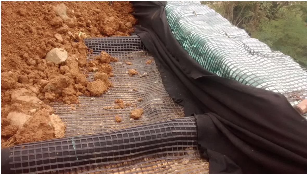
Figura 15. Instalación del Pipedrain en el muro MSE con geosintéticos.
