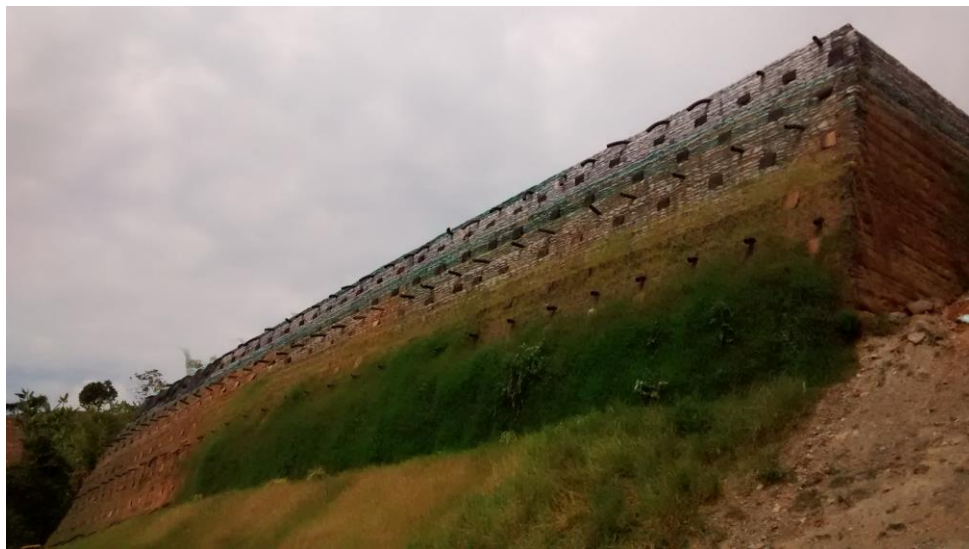
Figura 20. Vista general final del muro MSE con geosintéticos para recuperación vial Uribe-Sevilla en el sector la Cristalina municipio de Sevilla, Valle del Cauca.
