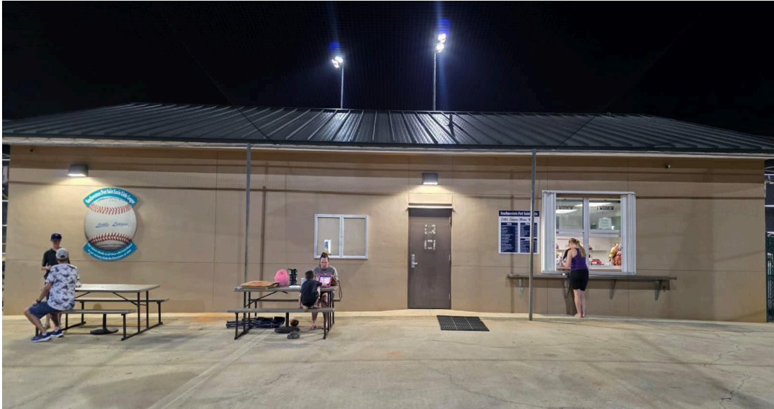
Figura 63. Estación de comidas
