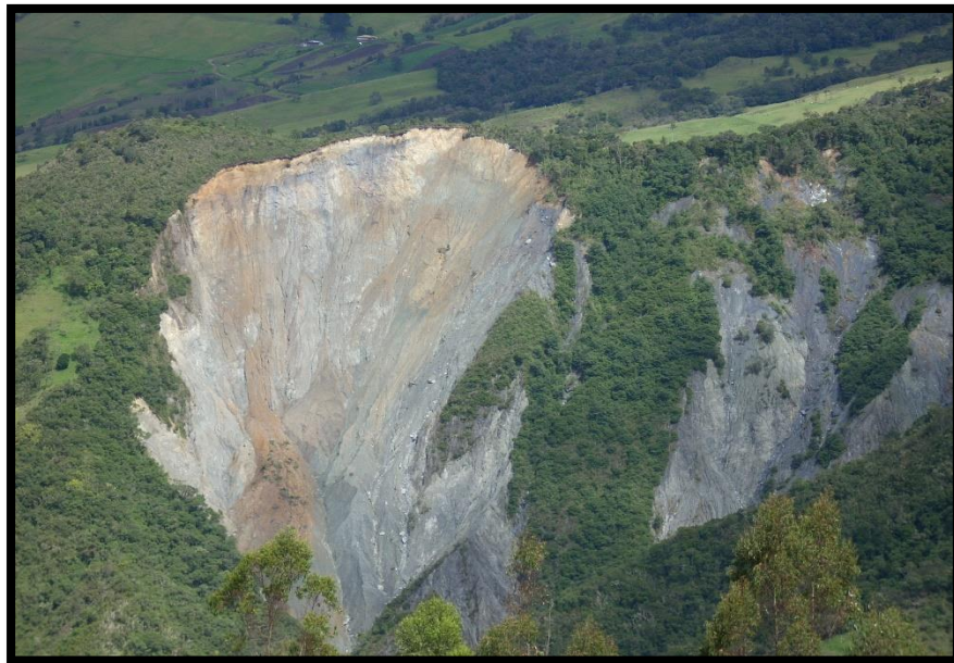
Figura 34. Fotografía del derrumbo azul
