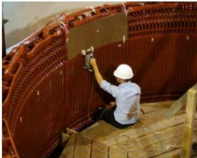
Figura 62. Reparación de un paquete de laminación
