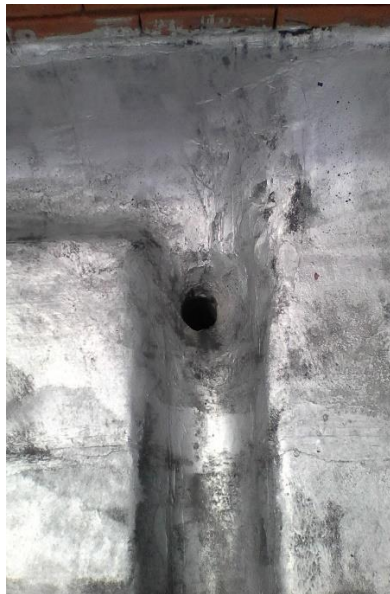
Figura 8.1. Material de cubierta edificio 320 (Facultad de Ciencias)
