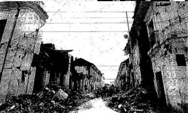
POPAYÁN.—La destrucción del centro de esta capital se aprecia en toda su magnitud. La parte histórica de Popayán fue borrada por el movimiento sísmico que causó la muerte a más de cien personas, heridas a otras 500. (Foto EL TIEMPO, de Diego Tobari).
