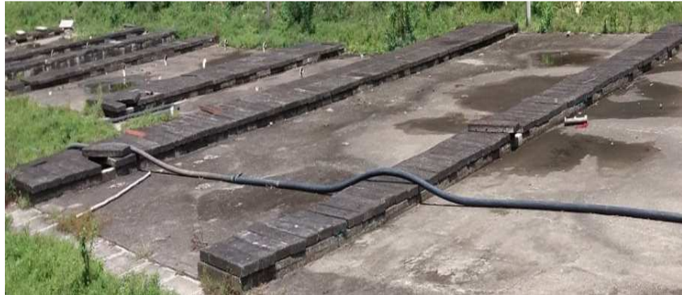
Filtro anaerobio de flujo ascendente. Fuente Propia
