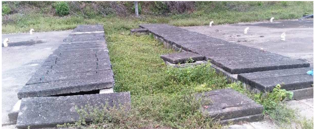
Tanques sépticos. Fuente: Propia
