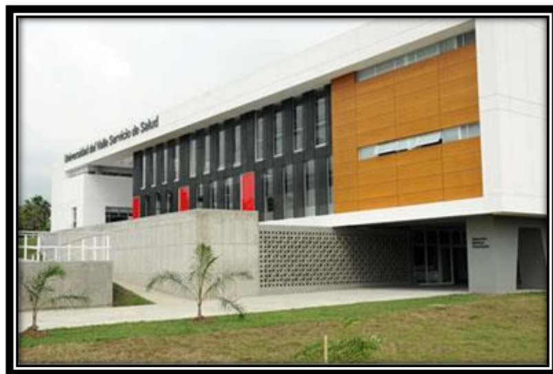
Figura 3: Servicio de salud, edificio Emilio Aljure, Univalle
