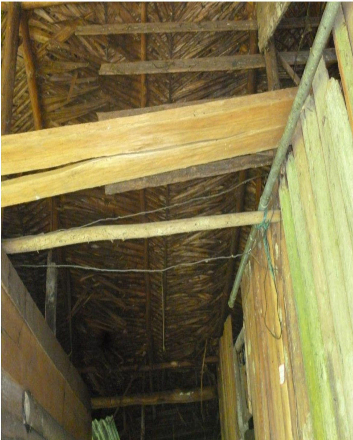
FIGURA N° 4 MATERIAL DE PAREDES Y TECHO Concejo comunitario de la vereda alto Potedó 2013-2014
