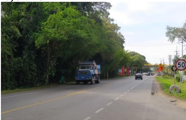
Carretera Jamundí – Santander de Quilichao, sentido Norte-Sur. Zona donde hay un supermercado.
