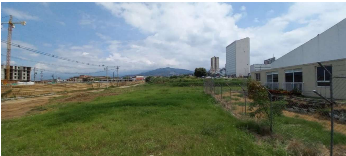
Figura 15 Construcción Primer Torre Habitacional Paraíso Central
