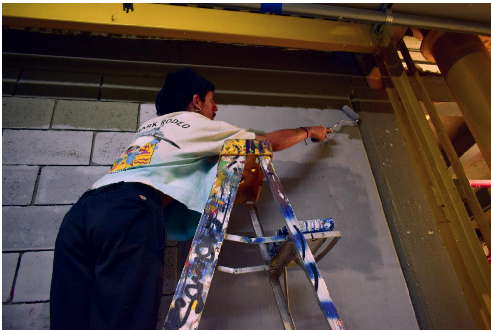
Imagen 28. Proceso de preparación de la pared.
