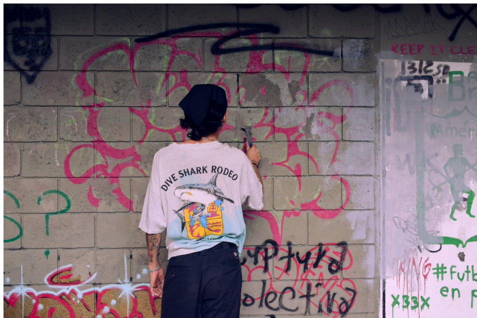
Imagen 27. Proceso de preparación de la pared.
