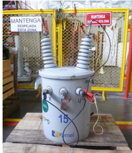
Figura 43. Montaje del transformador seleccionado.
