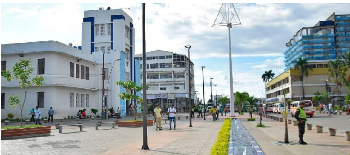
Imagen 5. Finalización de la construcción del Bulevar
