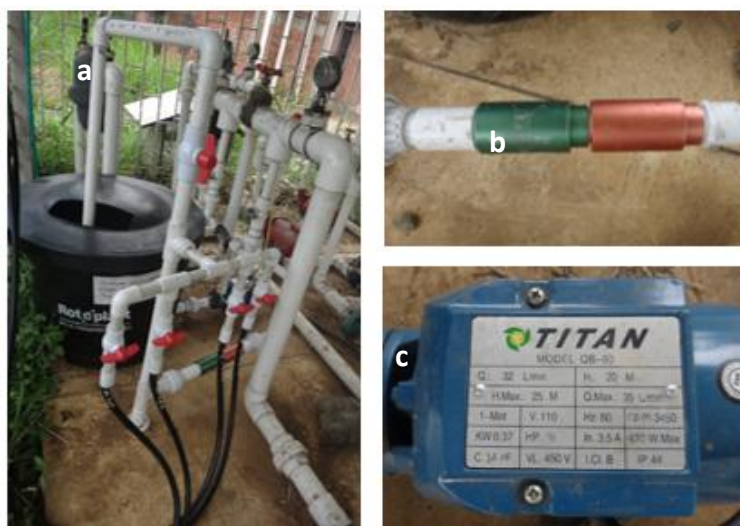
Fotografía 7. a. Sistema de recirculación de agua de riego con magnetizadores; b. Magnetizadores en serie; c. Detalle electrobomba.
