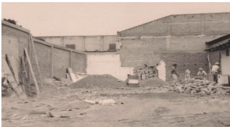
Figura 7. En 1982 compran terreno en la zona industrial de Yumbo, Valle del Cauca, Inicio de construcción y adecuaciones al terreno.
