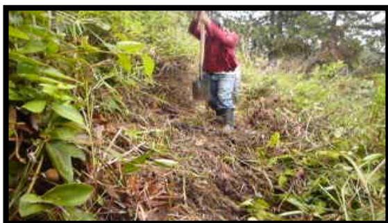
Ilustración 11. Trabajador encargado de realizar las zanjas, excavación lineal que se hace sobre el terreno.
