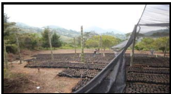
Ilustración 6. Montaje de la estructura para llevar a cabo la instalación de la polisombra.
