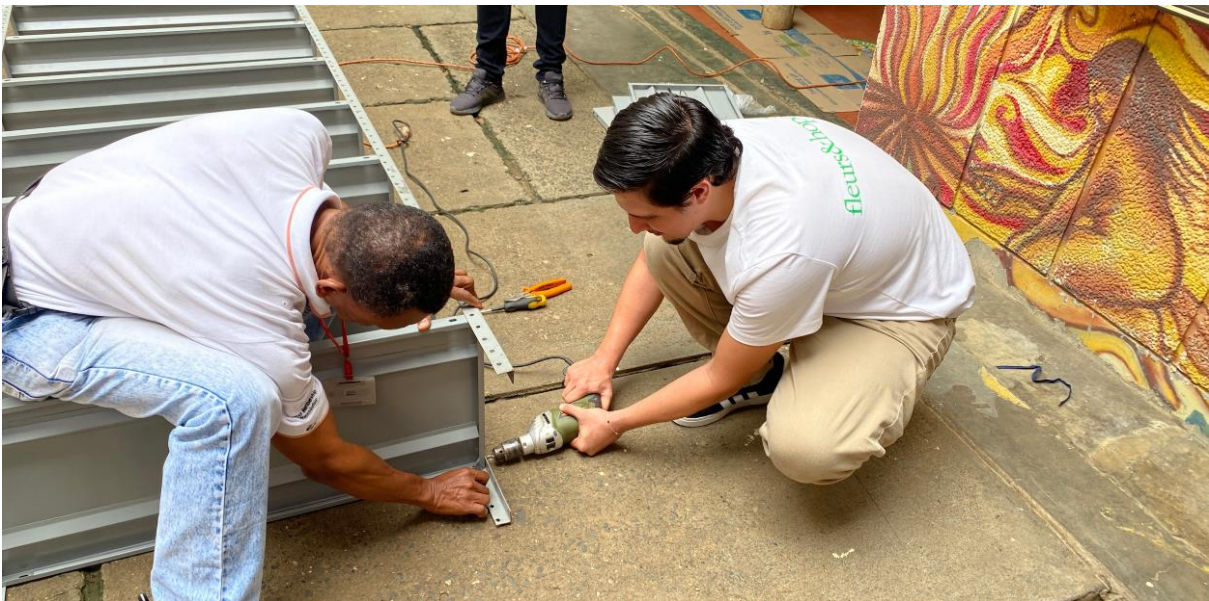
Ilustración 21. Instalación de estanterías con Walter Alegría.
