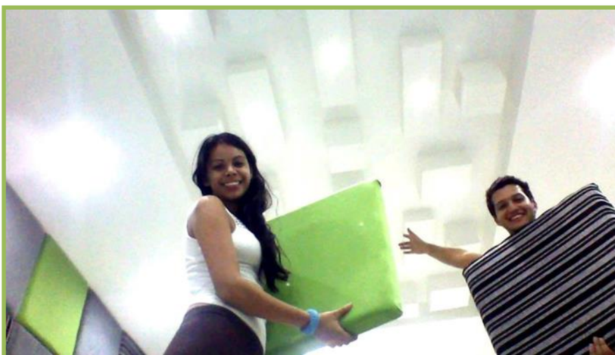
Imagen 3. Propietarios instalando aislamiento acústico en las paredes.
