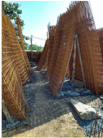
Figura 3.7. Almacenamiento vertical de mallas Fuente: Elaboración propia.
