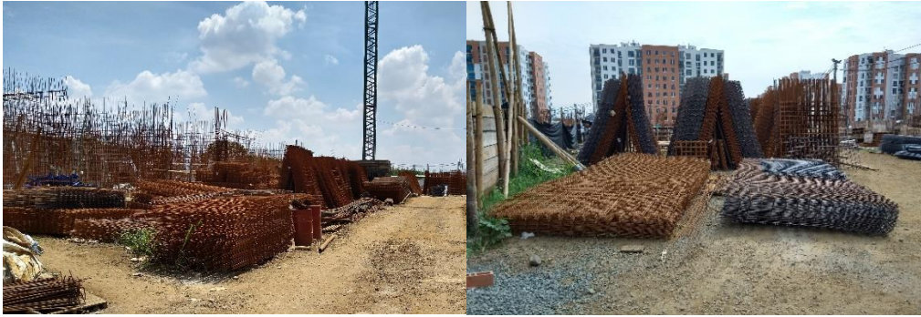
Figura 3.9. Instalaciones de almacenamiento de acero. Fuente: Elaboración propia.
