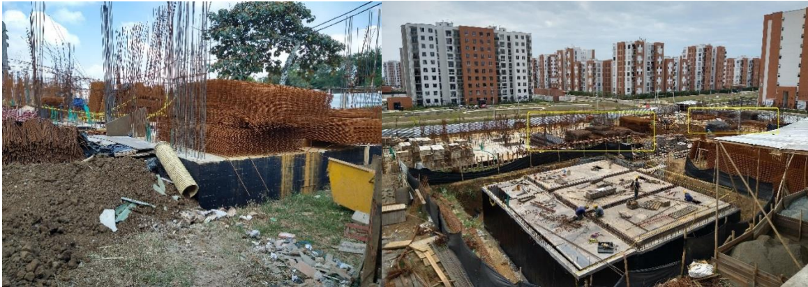
Figura 3.6. Almacenamiento de acero. Fuente: Elaboración propia.
