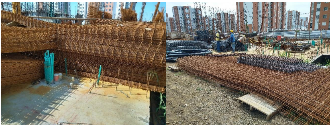
Figura 3.8. Almacenamiento horizontal. Fuente: Elaboración propia.
