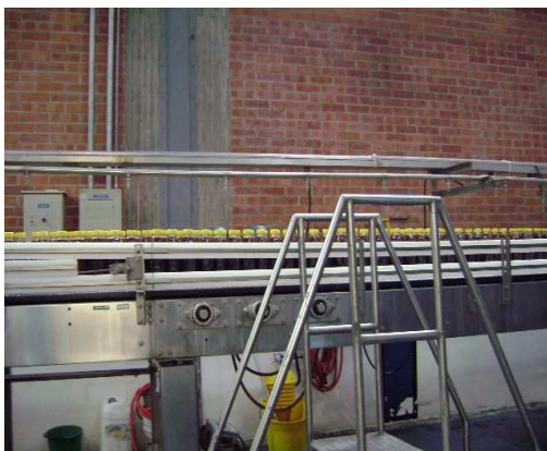
Foto 9. Duchas a la salida del Inversor
