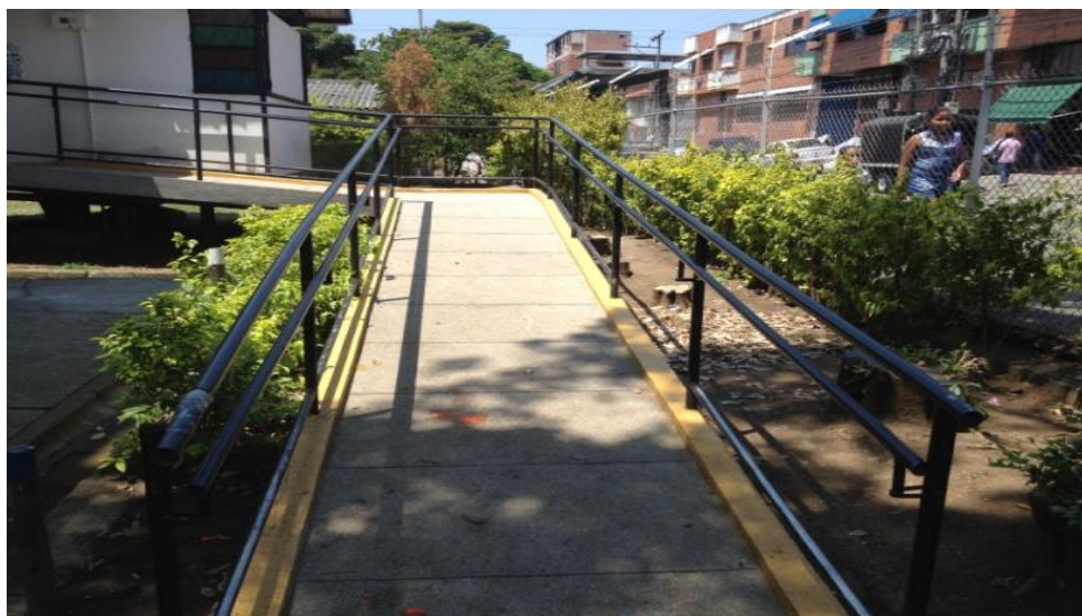
Figura 13. Imagen Rampas de acceso al baño para estudiantes en situación de discapacidad, sede San José.
