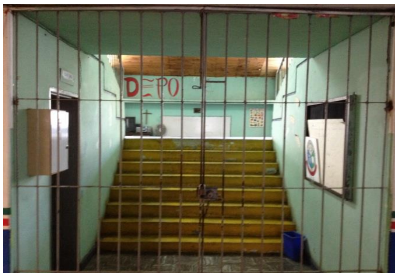
Figura 12. Escaleras de ingreso al gimnasio Foto: Geovanny Moncayo.
