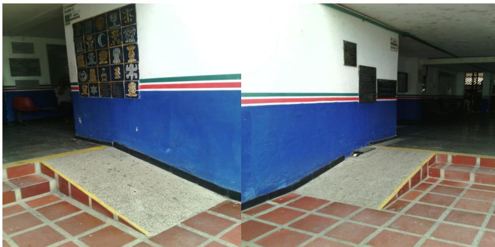
Figura 5. Rampas de ingreso al colegio. Foto: Mary Luz Guevara.
