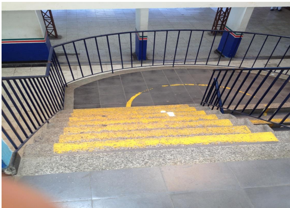
Figura 7. Escaleras para acceso al segundo piso de la sede principal, Institución Educativa República de Israel. Foto: Geovanny Moncayo
