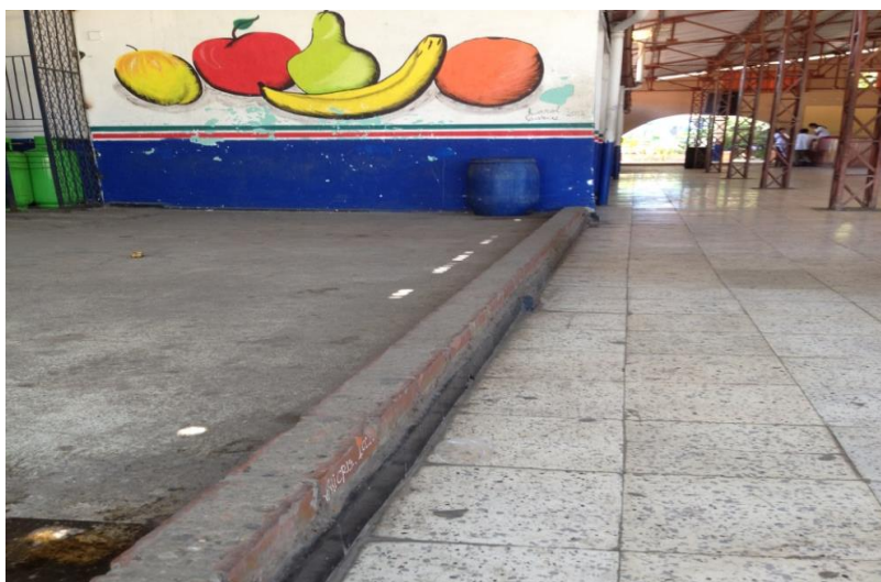
Figura 10. Muro que separa el coliseo de la tienda y papelería escolar. Foto: Mary Luz Guevara.
