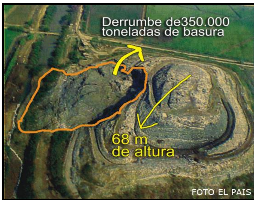
Figura 3. Derrumbe ocurrido sobre el canal CVC Sur en el 2001
